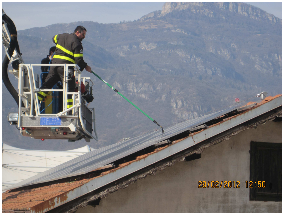
Figura 5-30: inizio prova con gel Prevento Solar
