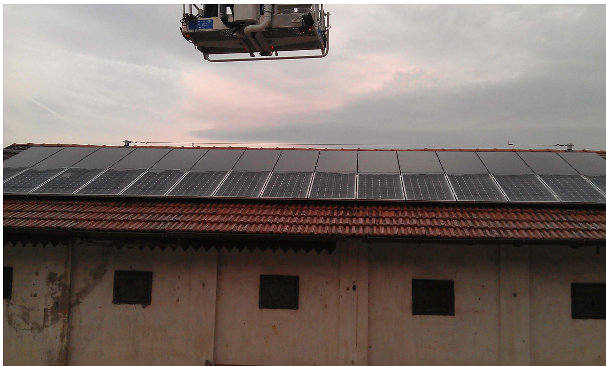
Figura 5-26: prova con Prevento Solar: copertura finale dei pannelli
