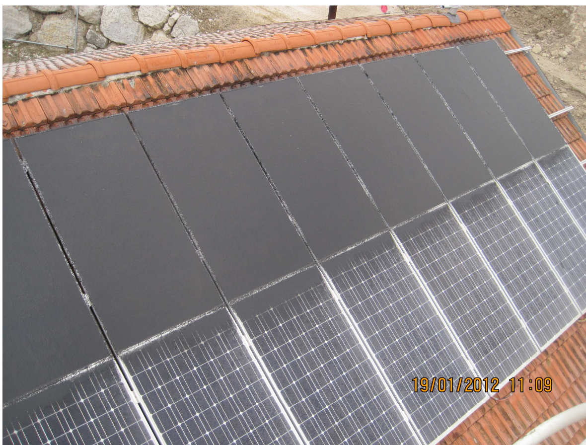
Figura 5-24: prova con Prevento Solar: copertura finale dei pannelli
