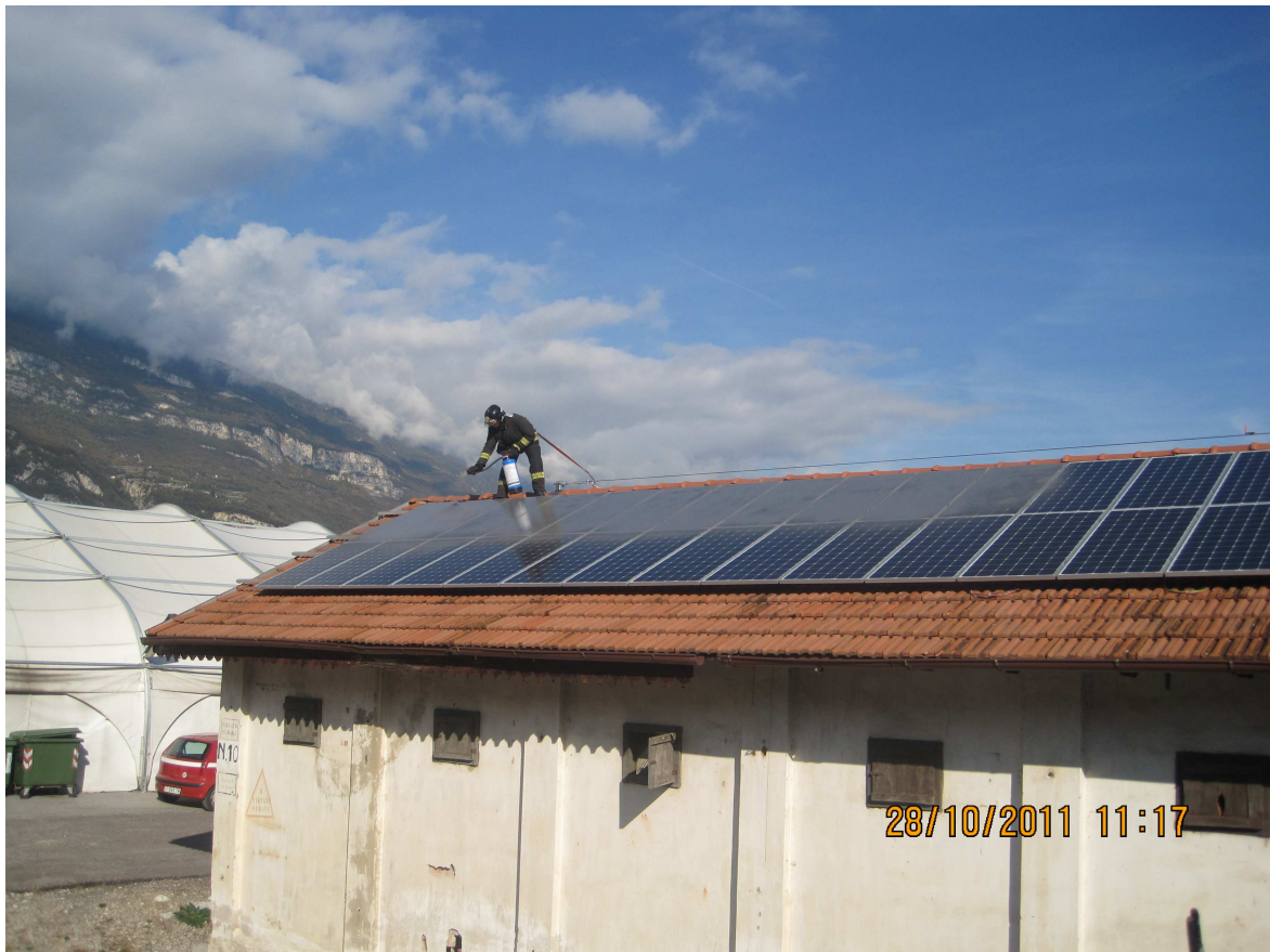
Figura 5-16: prova con PreventoSolar: inizio seconda spruzzata, copertura dei primi 7-8 pannelli
