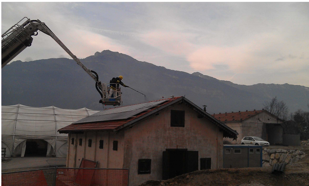
Figura 5-23: prova con Prevento Solar: prima spruzzata
