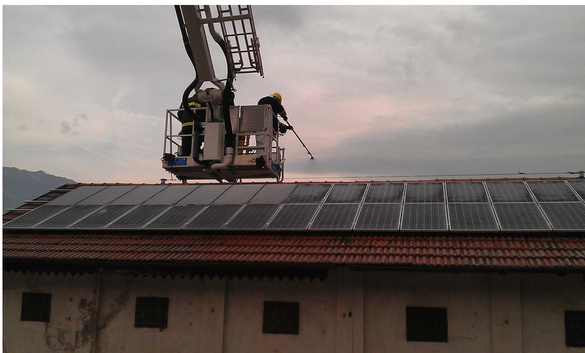
Figura 5-22: prova con Prevento Solar: prima spruzzata
