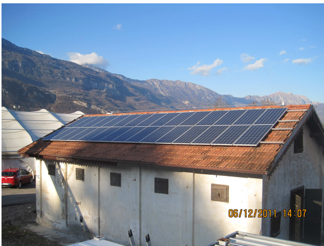
Figura 5-4: Prova con CAFS: situazione iniziale
