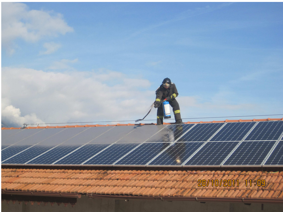
Figura 5-15: prova con PreventoSolar: fine primo spruzzata, coperti circa 7-8 pannelli
