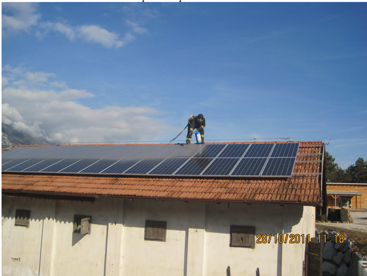
Figura 5-17: prova con PreventoSolar: fine seconda spruzzata, copertura dei primi 10-11 pannelli
