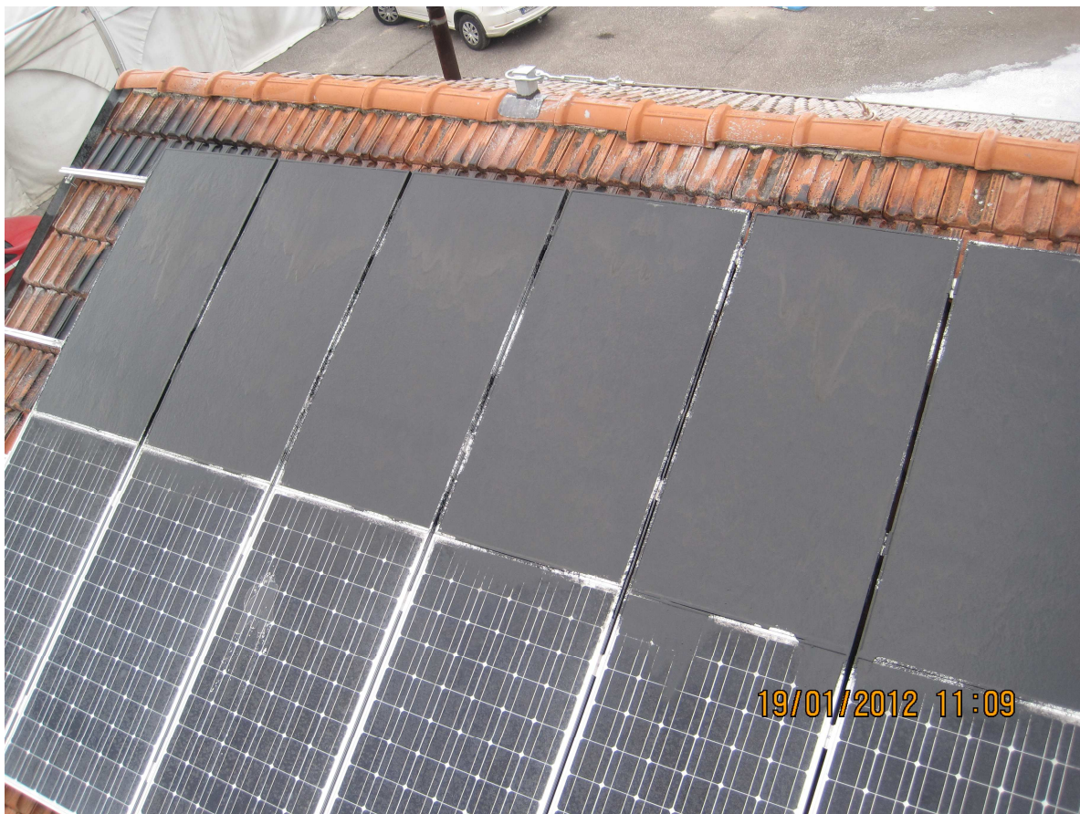
Figura 5-25: prova con Prevento Solar: copertura finale dei pannelli
