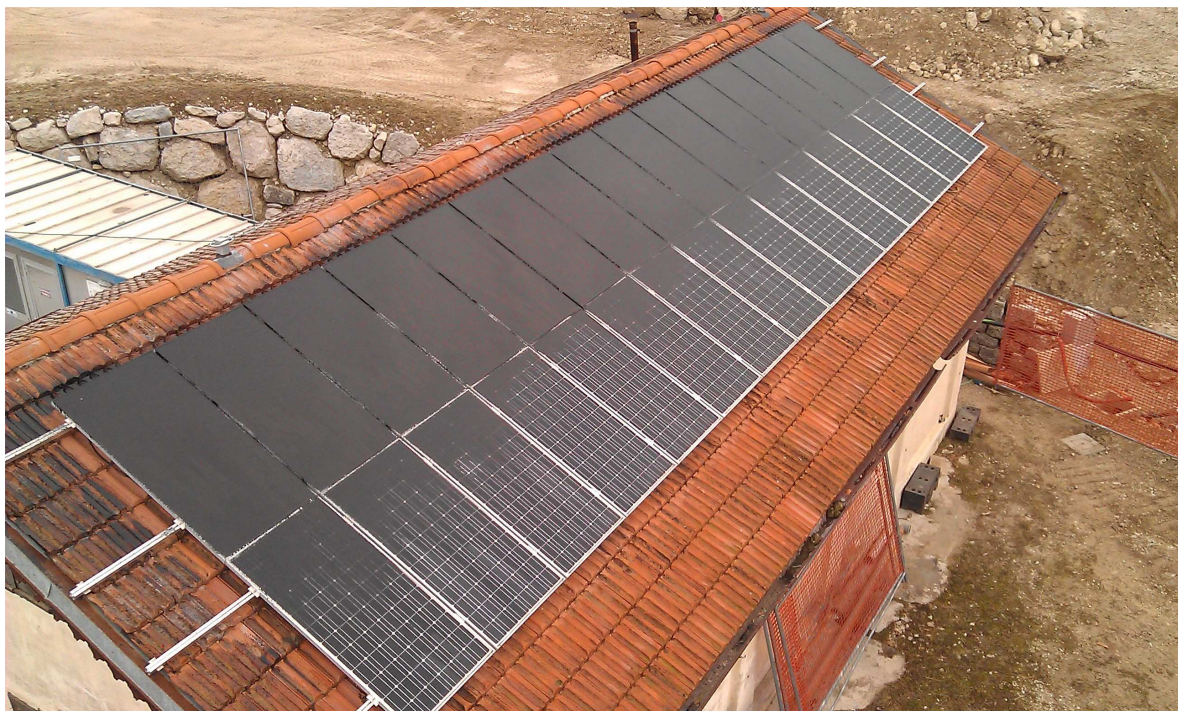
Figura 5-27: prova con Prevento Solar: copertura finale dei pannelli
