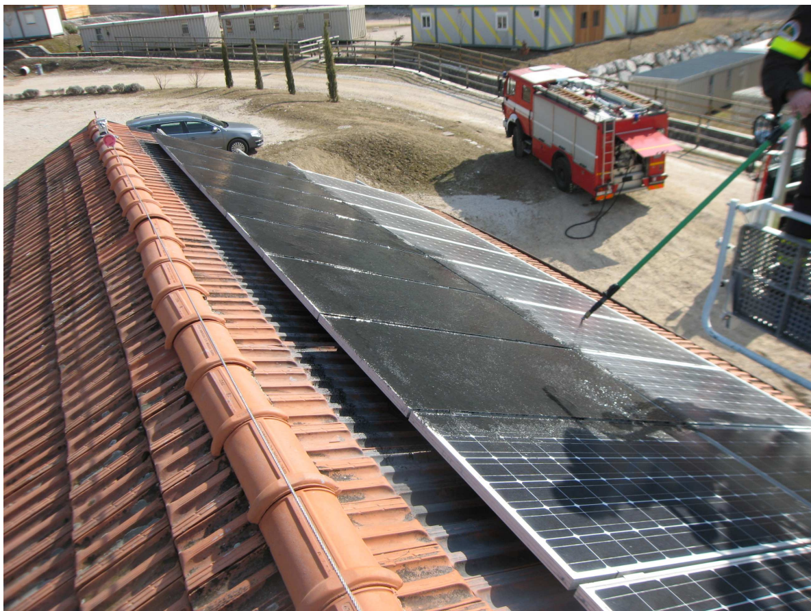
Figura 5-31: prova con gel Prevento Solar: copertura di metà pannelli
