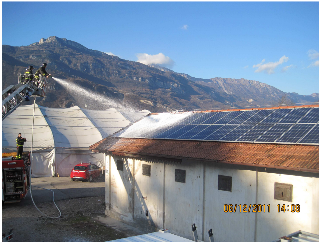
Figura 5-5: prova con CAFS: fase di schiumaggio
